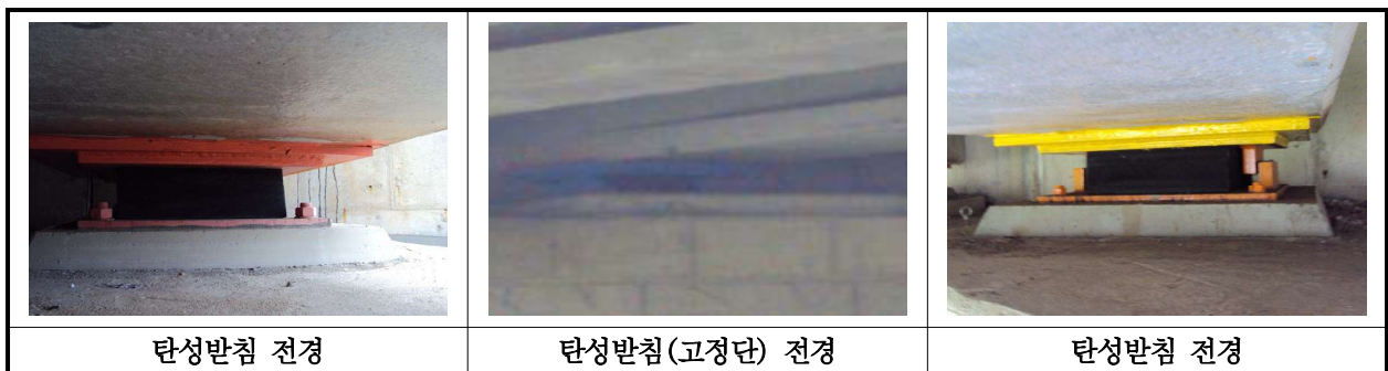
【사진 41.3.10】 교량받침 전경
