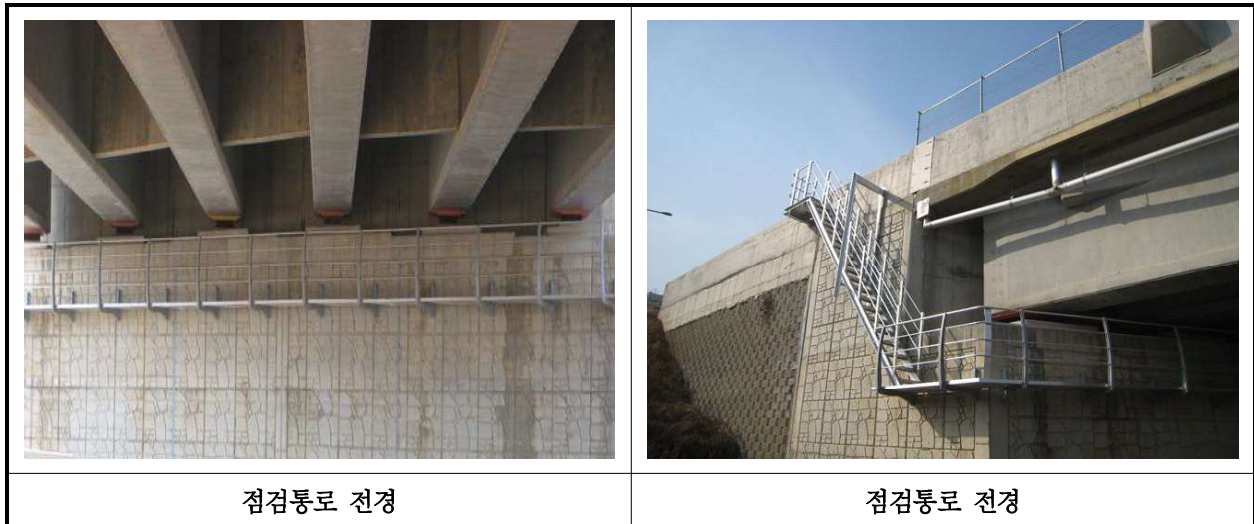
【사진 41.3.23】 교량 점검시설 전경
