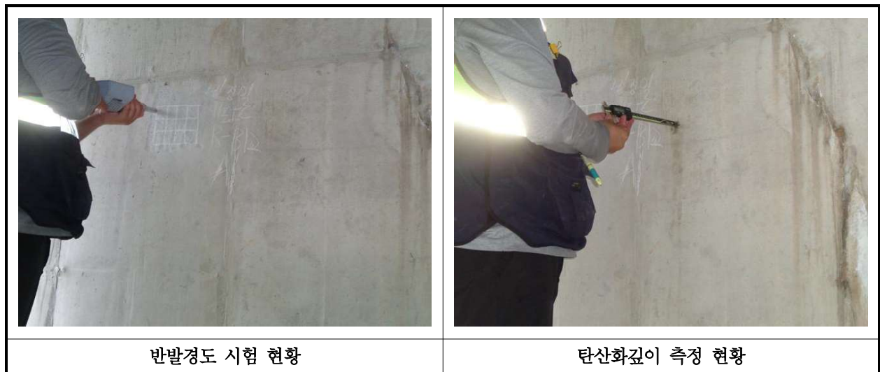
【표 41.4.1】 콘크리트 내구성조사 현황
