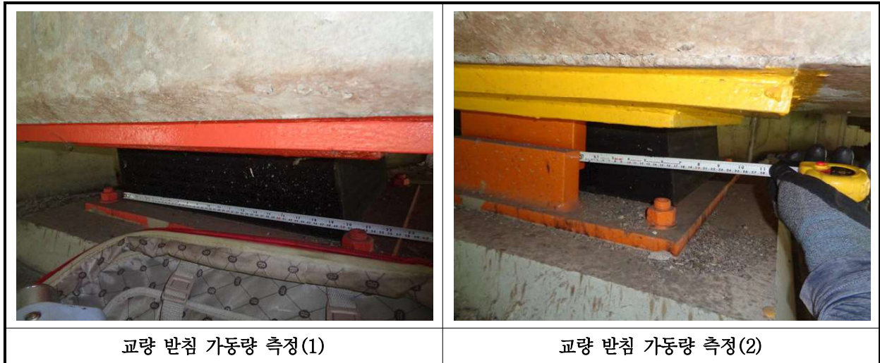
【사진 41.3.13】 교량받침 이동량 측정
