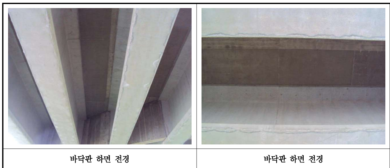
【사진 41.3.2】 바닥판하면 전경
