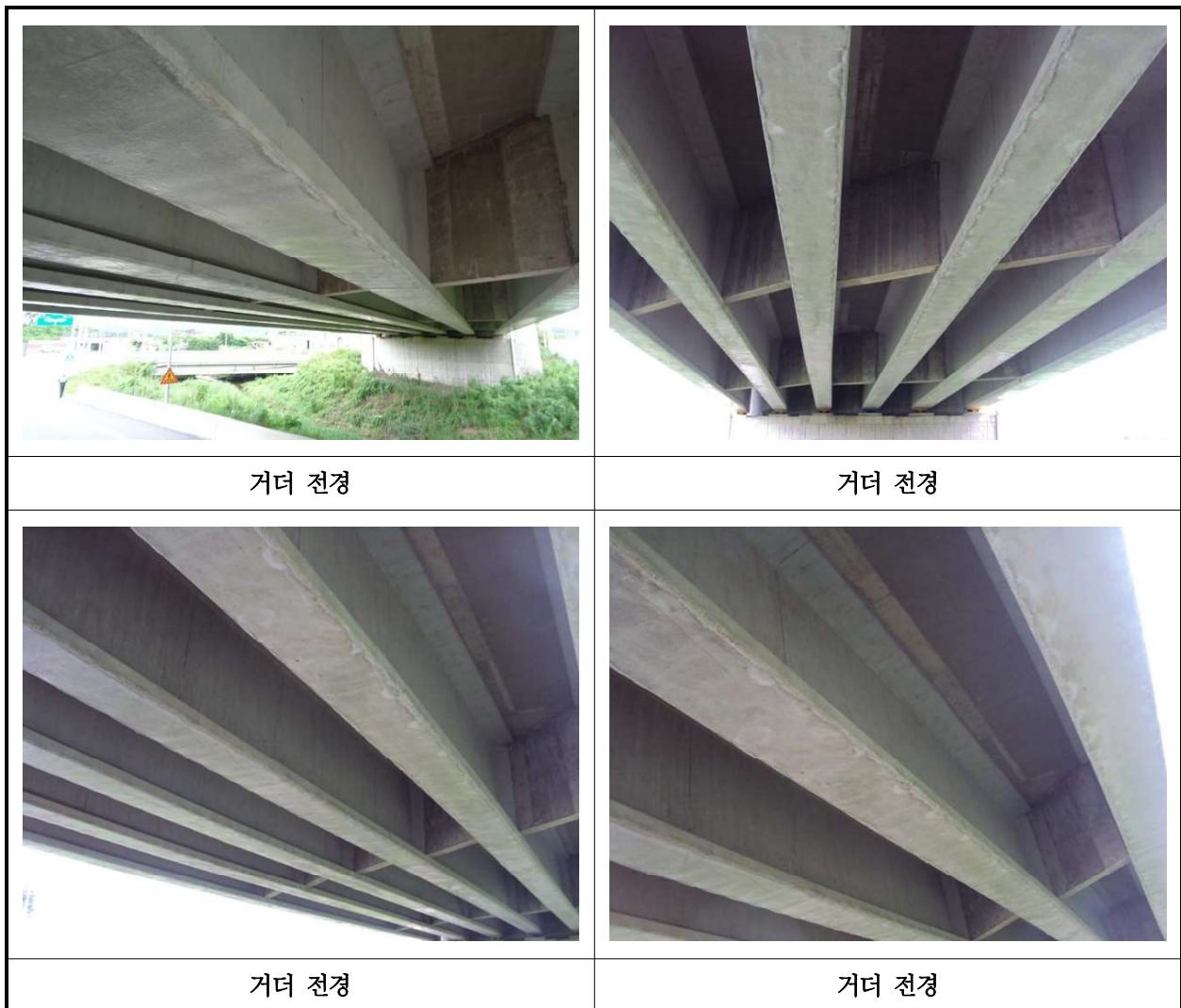
【사진 41.3.4】 거더 전경
