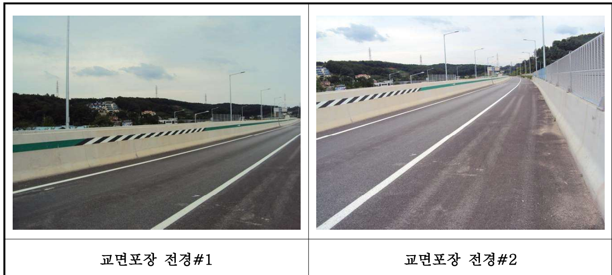
【사진 41.3.17】 교면포장 전경
