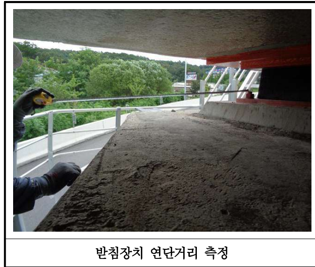
【사진 41.3.12】 교량받침장치 연단거리측정
