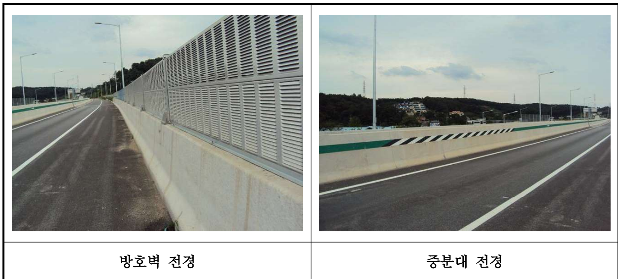
【사진 41.3.21】 방호벽 및 중앙분리대 전경
