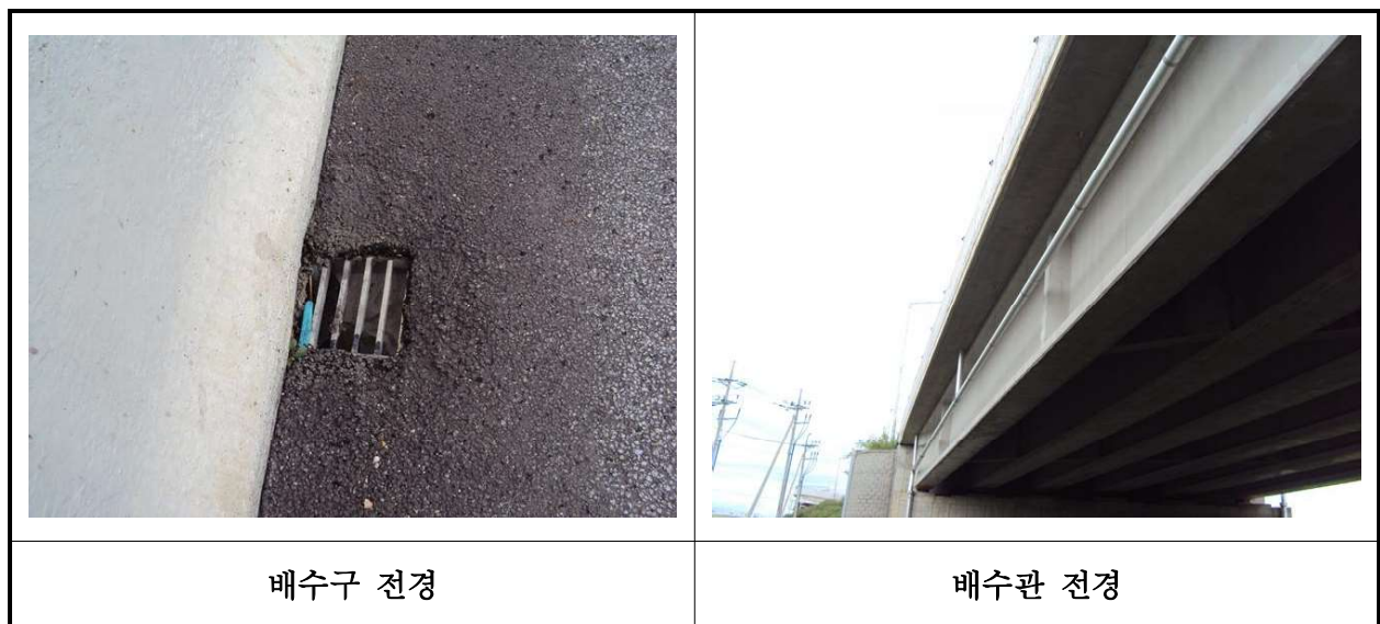
【사진 41.3.19】 배수시설 전경
